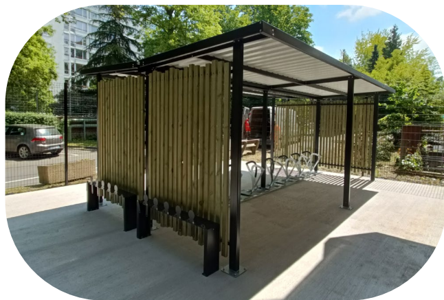
Un projet d'abri pour 16 vélos avec dalle à destination des salariés de l'hôpital privé le Bois à Lille (Source : Urbanéo).
