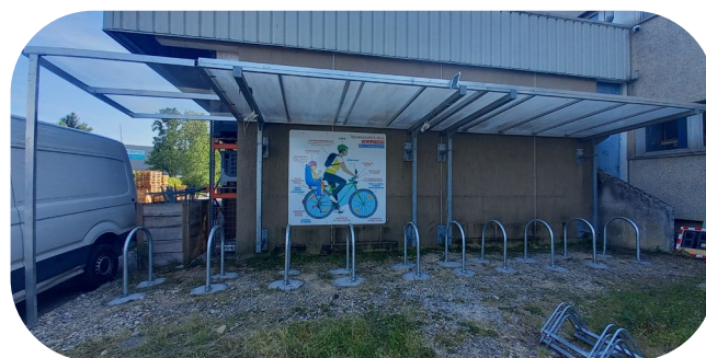
Un abri ouvert de stationnement vélo low-tech (Source : Self Signal).
